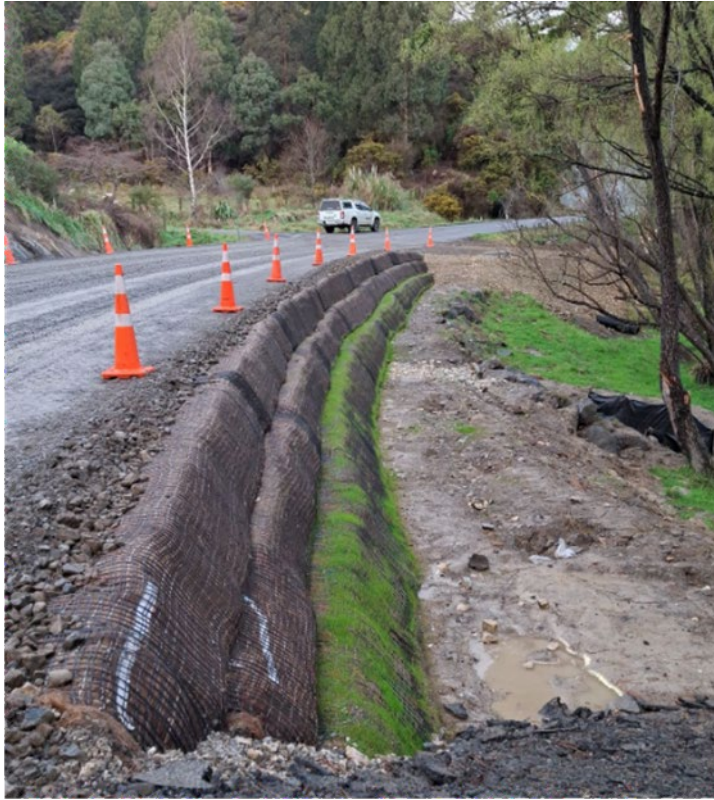
Route 52/157 MSE wall
